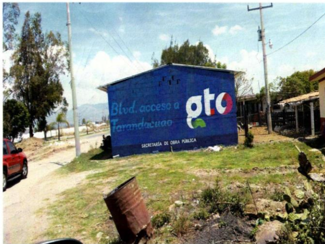
10.- Salida habilitada al libramiento Acámbaro-Maravatío boulevard de acceso a Tarandacuao, Gto.
