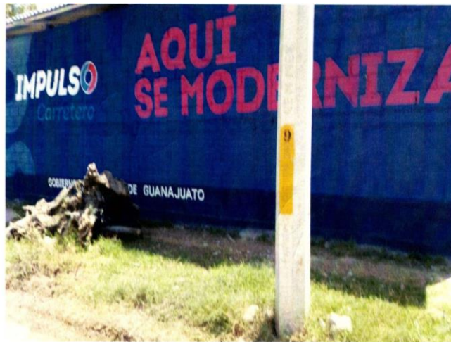
10.- Solista habilitada al libramiento Acámbaro-Maravatio, boulevard de acceso a Tarandacua, Gto.
