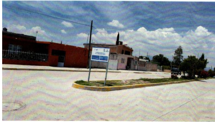
1.- Lehero metálico en la calle Emiliano Zapata en la comunidad de San José de Porto, perteneciente al municipio de Tarandacua.
