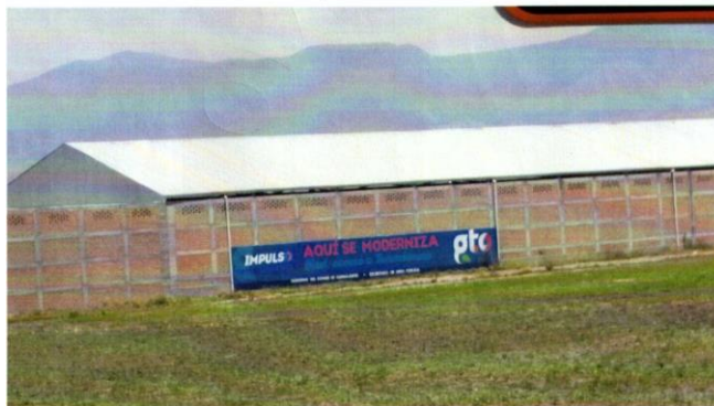
11.- 300 metros hacia el sur del cruceo Acámbaro-Maravatio del boulevard de acceso a Tarandacua; Gto.
